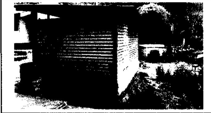
Foto 2: Estructura de soporte de la cocina de madera en mal estado
