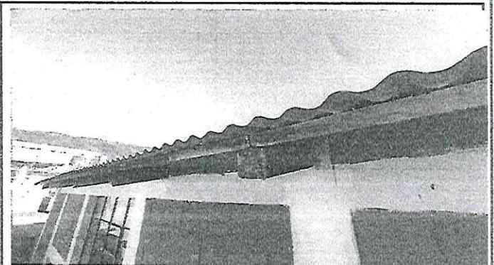
Foto 2: cambio de costaneras para fijacion de laminas
