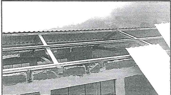
Foto 2: costaneras de metal para fijacion de laminas acanaladas
