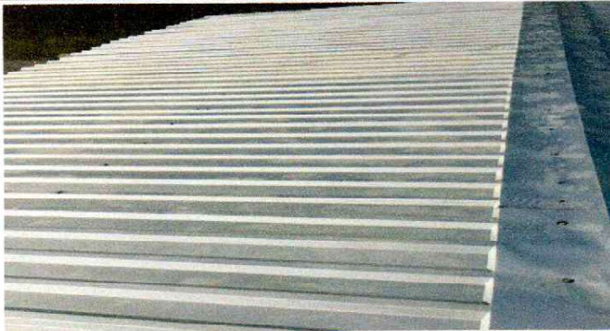
Foto 1: Sustitución de láminas, por láminas troqueladas calibre 24.
