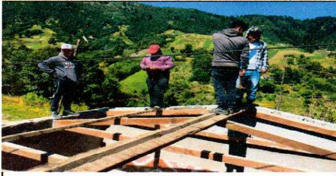
Foto 1: Sustitución de láminas, por láminas troqueladas calibre 24.
