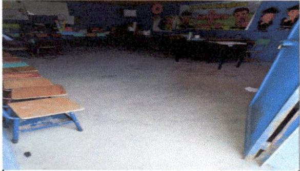
Foto 3: PISO DE CONCRETO SE IMPLEMENTARA CERAMICO
