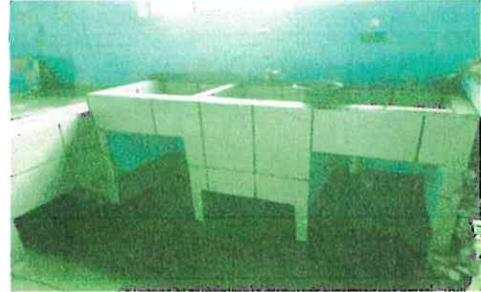
Foto 2: Sustitución completa de Pila en mal estado y colocación de gabinetes de concreto
