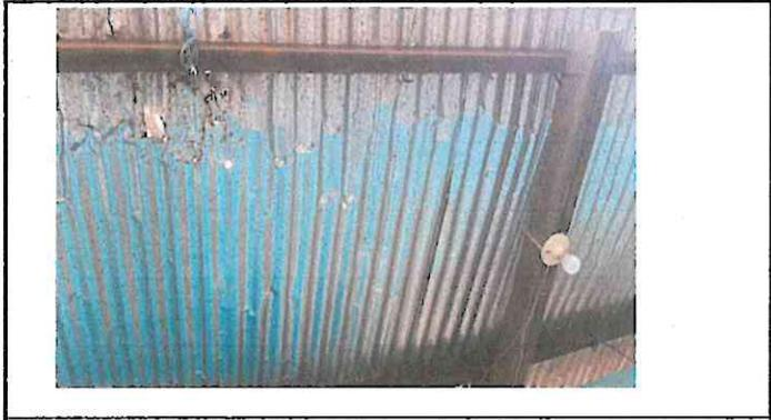
Foto 4: techo del salón de computo en mal estado
