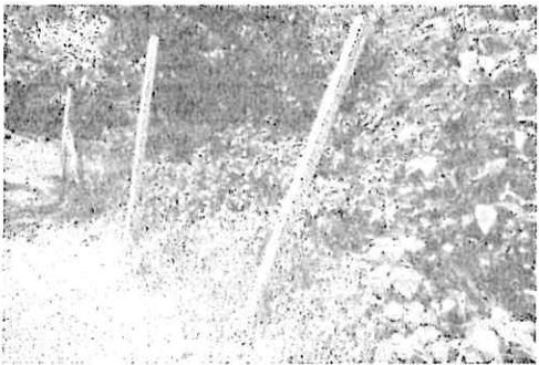
se circulará la parte perimetral con tubos galvanizados, se fundira y tenzara con Malla y alambre de puas
