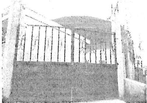
**Foto1:** Sustitución de Portón , El Portón se encuentra ya deteriorado, picado con mucho oxido
