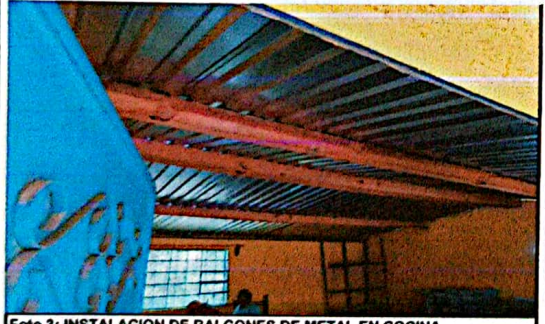
Foto 3: INSTALACION DE BALCONES DE METAL EN COCINA
