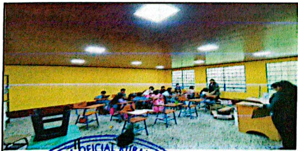
Foto 11: INSTALACIÓN DE CIELO FALSO EN AULAS
