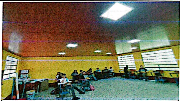
Foto 8: INSTALACIÓN DE LAMPARAS DE ILUMINACIÓN EN CIELO FALSO
