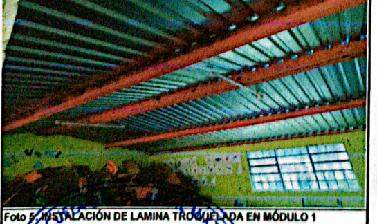
Foto 5: INSTALACIÓN DE LAMINA TRÓQUELADA EN MÓDULO 1
