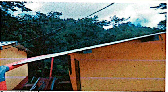
Foto 4: INSTALACIÓN DE LAMINA
