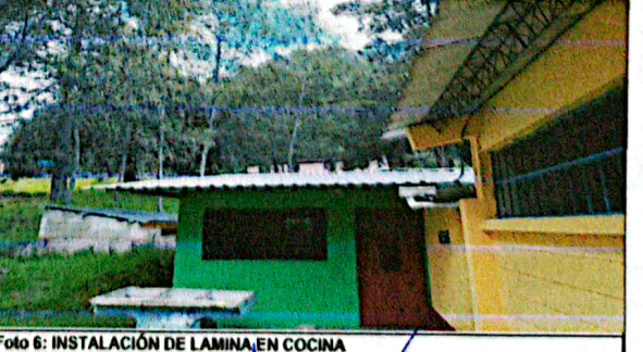
Foto 6: INSTALACIÓN DE LAMINA EN COCINA
