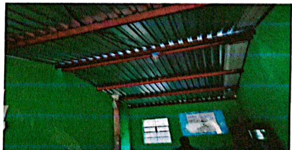
Foto 12: INSTALACIÓN DE LAMINA TROQUELADA EN MÓDULO DE AULAS
