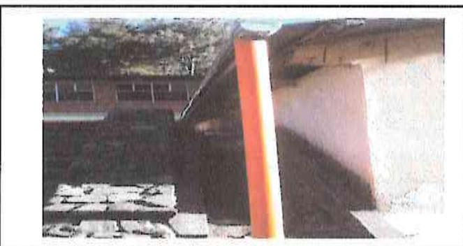
FOTO 6: Canaletas colocadas y bajada de agua pluvial ya finalizada.
