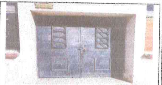
FOTO 4: Mantenimiento a portón con anticorrosivo
