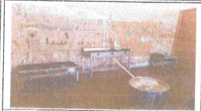
FOTO 1: Remodelación áreas de cocina
