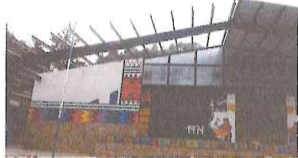
FOTO 2: Proceso de sustitución de láminas rotas con un avance del 50 por ciento.
