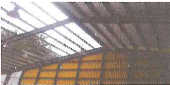
FOTO 5: Proceso de sustitución de láminas nuevas troqueladas con avance del 50 por ciento.
