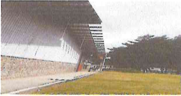
FOTO 1: Proceso de sustitución de láminas dañadas del techo del auditorio con un avance del 80 por ciento.
