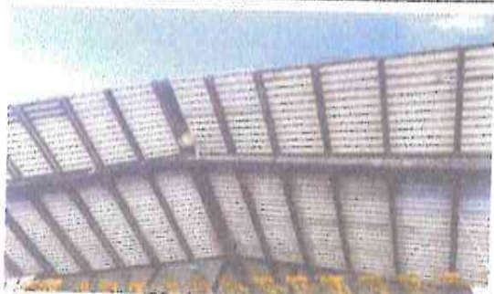
FOTO 5: Las láminas fibrocemento del auditorio deterioradas por los años de haber construido.
