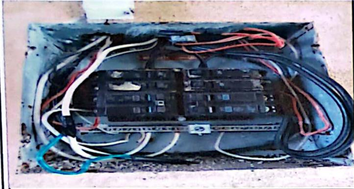
Foto 1: Tablero de Flipones de la planta baja
