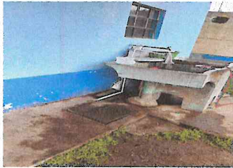
Foto 1: Sustrucción de pila de cemento de dos lavaderos
