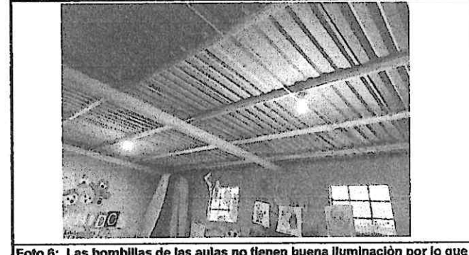
Foto 6: Las bombillas de las aulas no tienen buena iluminación por lo que es necesarios cambiarlas por lámparas LED tipo ahorradoras.
