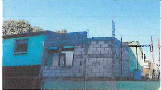
Foto 2: Durante la construcción de la pared de la cocina, sin techo.
