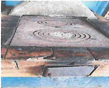
Foto 1: Sustitución de plancha en mal estado.
