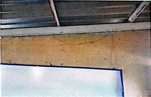
Foto 1: Cables eléctricos en mal estado
