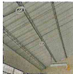
Foto 6: Reparación de lamparas.
