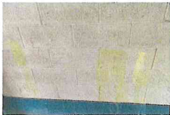
Foto 5: Pintura a paredes del interior de cocina
