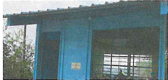
Foto 4: Instalación de canal de metal
