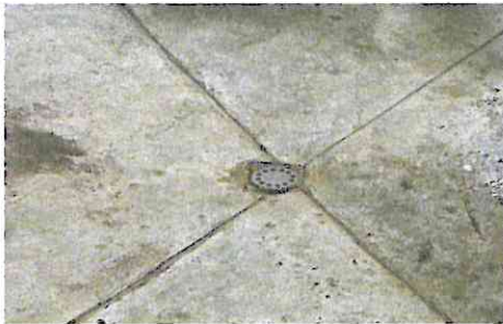
Foto 3 colocación piso granito ya que es concreto
