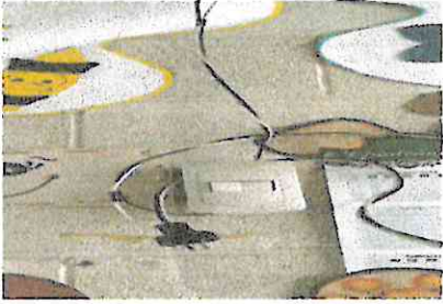
Foto 7: Sustrucción de interruptor
