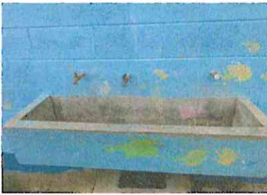
Foto 15: Reparación de lavamanos
