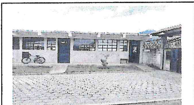
Foto 3: Pintada de todas las instalaciones del establecimiento exterior e interior
