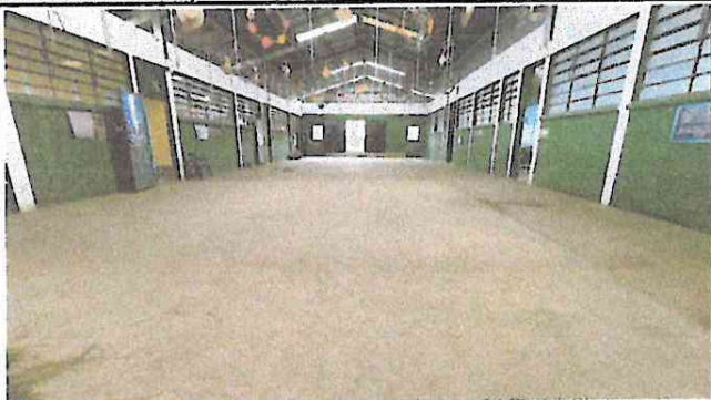
Foto 1: Colocación de piso
