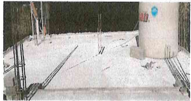
Foto 4: Finalización de sustitución de lamina
