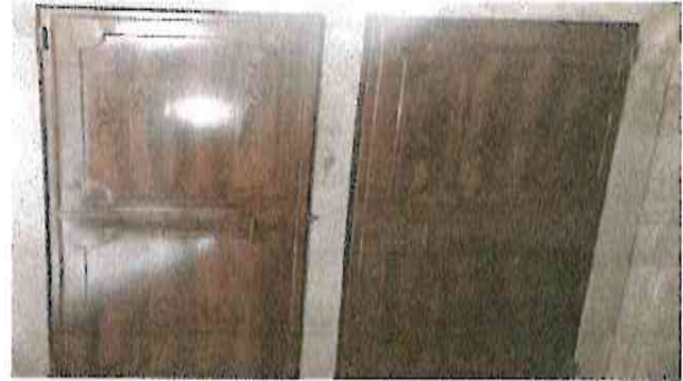
Foto 2: Finalización de sustitución de puerta en mal estado
