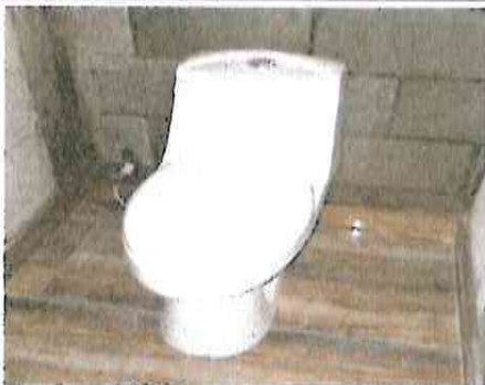
Foto 5: Finalización de Baños en mal estado
