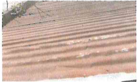
Foto 4: Sustrucción de laminas
