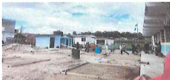
Foto 1: Avance del 40% Losa de Patio.
