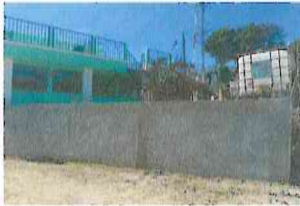
Foto 3: Culminación del muro perimetral al 100%
