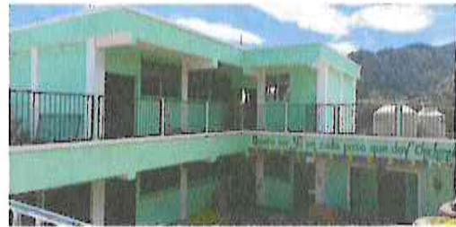
Foto 4: Culminación de la sustitución de pintura interior y exterior al 100%
