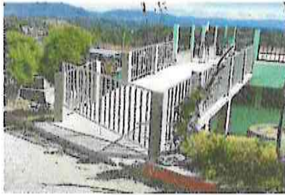
Foto 1: Finalización de piso aereo al 100%
