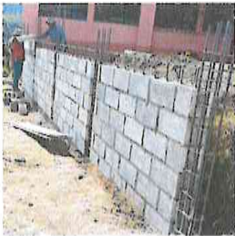
Foto 3: Sustitución de muro perimetral con un avance del 60%
