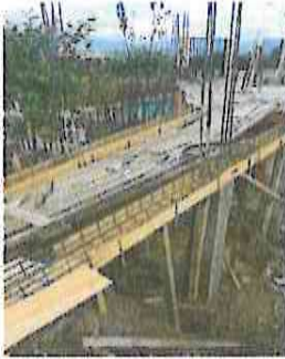
Foto1. Sustitución de piso aéreo con la armadura con un avance del 50%
