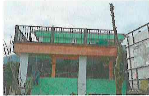
Foto 4: Avance de la pintura interior y exterior a un 50%
