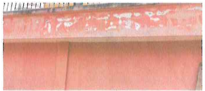
Foto 4: Pintura deteriorada.
