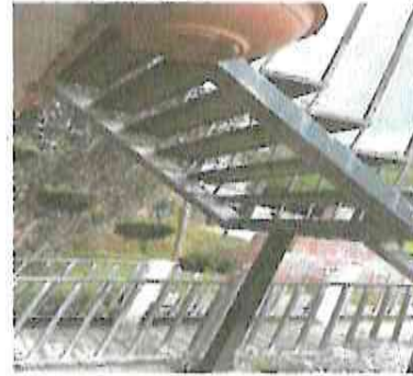
Foto 2: Sustitución de piso estructural por piso fijo de concreto.
