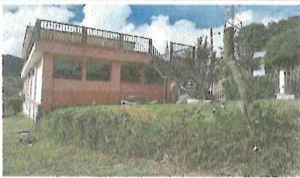
Foto 3: Sustitución de cerco natural por muro perimetral.
