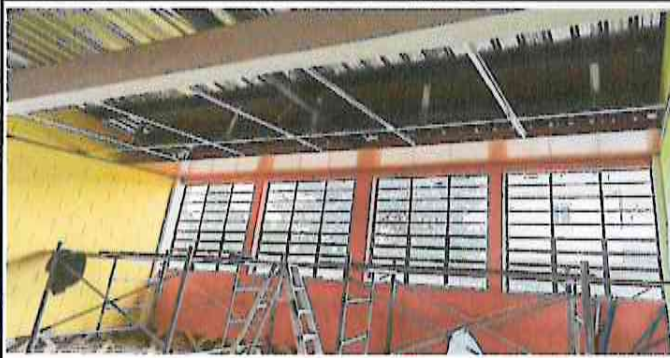
ESTRUCTURA DE TECHO: AVANCE 60%
