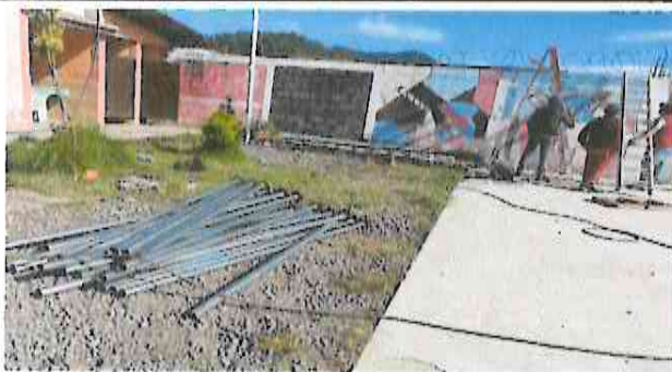
MURO PERIMETRAL: AVANCE 40%
