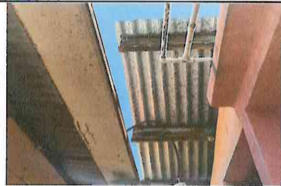
CANALES Y BAJADAS DE AGUA PLUVIAL: AVANCE 65%
