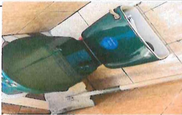
SERVICIOS SANITARIOS Y SUS ACCESORIOS: AVANCE 80%
