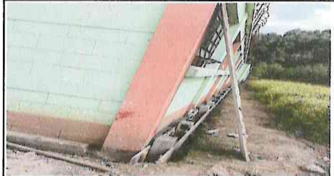
CUNETA DE CONCRETO: AVANCE 70%
