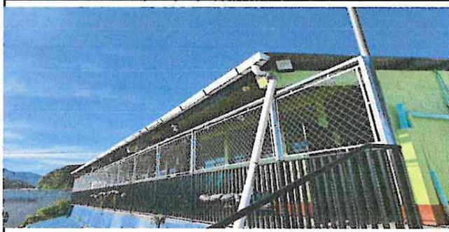
Foto 1: Mantenimiento a barandas, colocación de malla.
