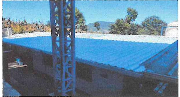
FOTO 2: CUBIERTA DE LÁMINA. Por deterioro, óxido, perforación de techo la cual se filtra agua dentro del aula y cocina.
