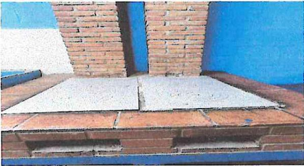
FOTO 3: Sustitución de planchas por desgaste y óxido.
