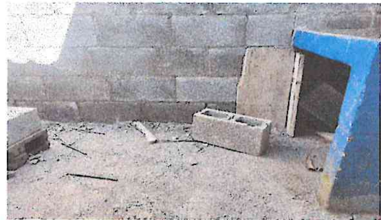
Foto 4: cerco para tapan un área abierta.
