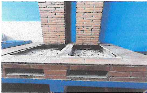
FOTO 3: Sustitución de planchas por desgaste y óxido.
