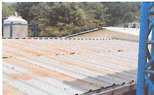
FOTO 2: CUBIERTA DE LÁMINA. Por deterioro, óxido, perforación de techo la cual se filtra agua dentro del aula y cocina.
