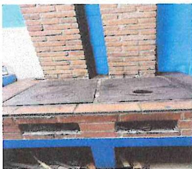
FOTO 3: Sustitución de planchas por desgaste y óxido.
