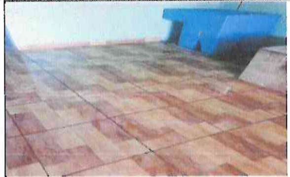
Foto 2: Finalización de colocación de piso de cocina 100%
