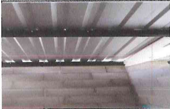
Foto 1: Finalización de ciablerta de techo en cocina 100%
