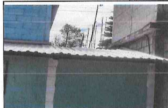
foto 4: Finalización colocación de lamina en la cocina 100%
