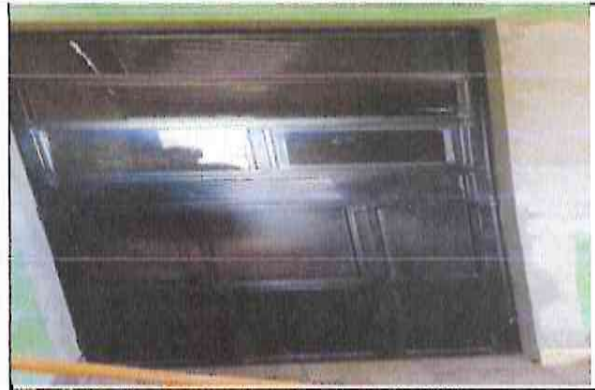
Foto 2: Finalización de colocacion de puerta 100%
