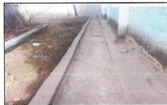
foto 6: finalización de red de drenaje 100%
