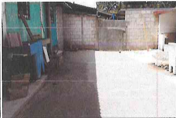
foto 3: Finalización de loza de patio 100%
