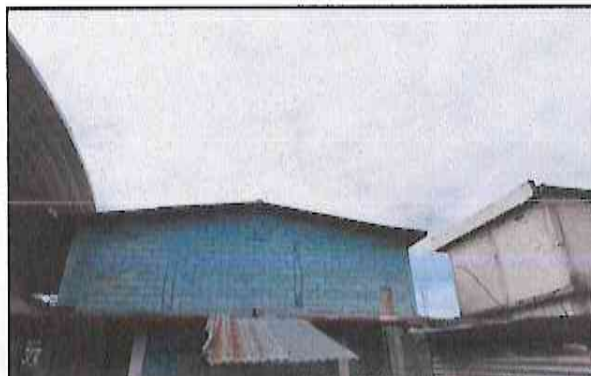
foto 4: sustitucion de laminas 50%
