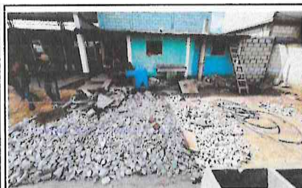
foto 3: loza de patio avance 50%
