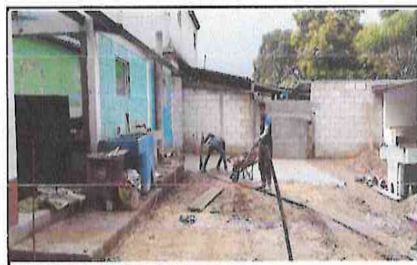
foto 6: mantenimiento de drenaje 50%
