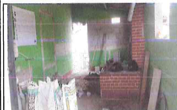
foto 5: ampliacion lado de la cocina
