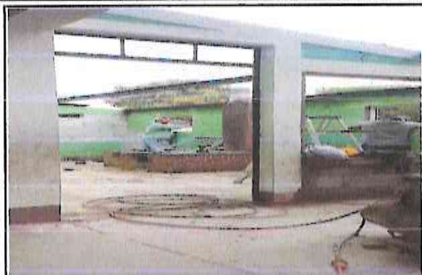
Foto 1: Cubierta de techo de cocina avance del 40%
