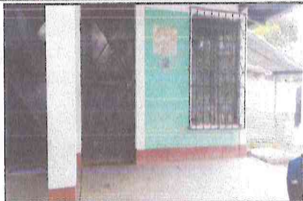
Foto 8: sustitución de Puerta
