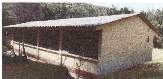
Foto 9: Vista lateral de modulo de aulas.
