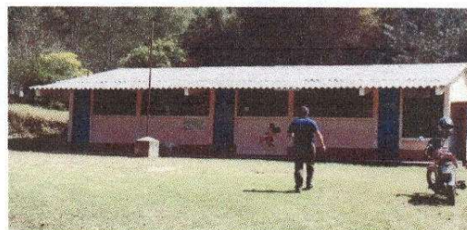
Foto 10: Vista general de modulo de aulas.
