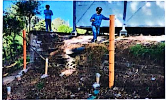
Foto 2: La parte que queda del muro de contención
