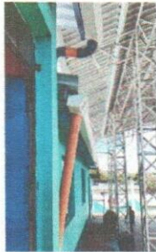
Foto 9: Mejoramiento de canales y bajadas de agua pluvial.
