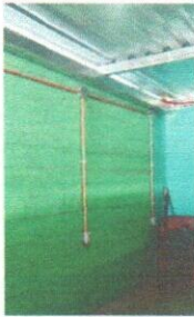
Foto 7: Mejoramiento de techo y sistema electrico en salon de computo.
