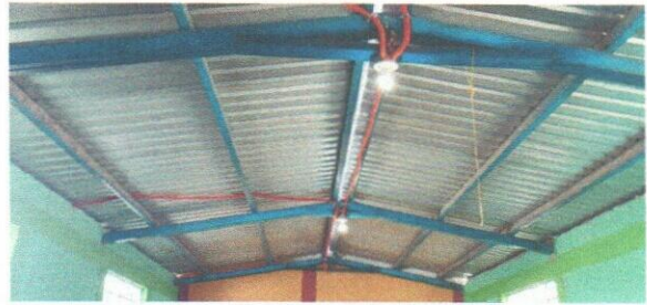
Foto 8: Mejoramiento de techado en aulas.
