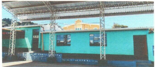
Foto 10: Vista general de mejoramiento de canales.
