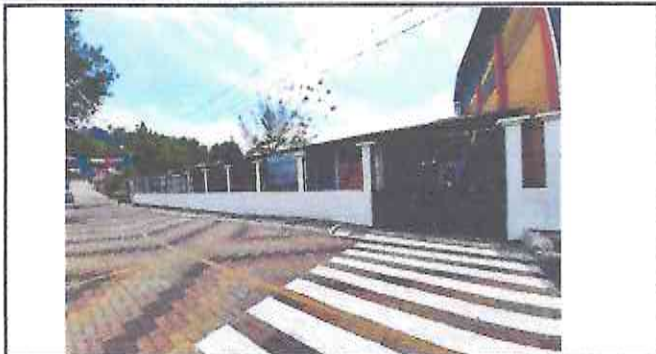
Foto 1. Fachada en proceso
