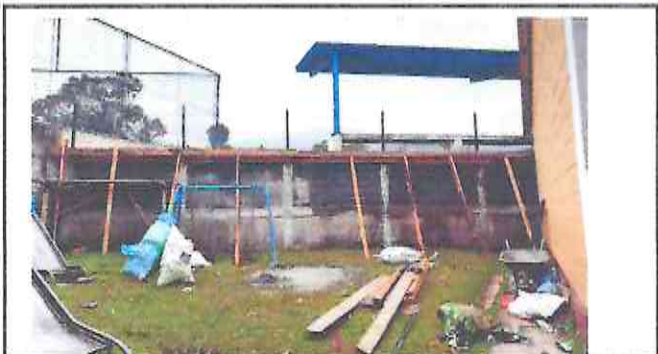
Foto 4. Subiendo block con las columnas y solera de humedad
