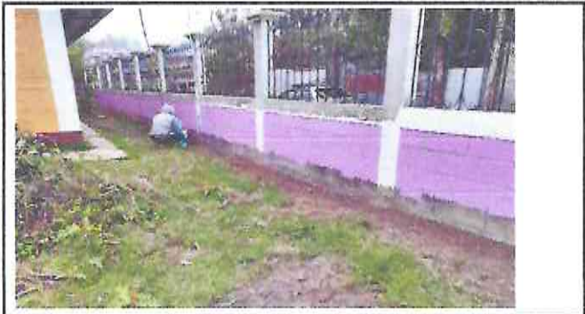
Foto 2. Muro de circulación en proceso
