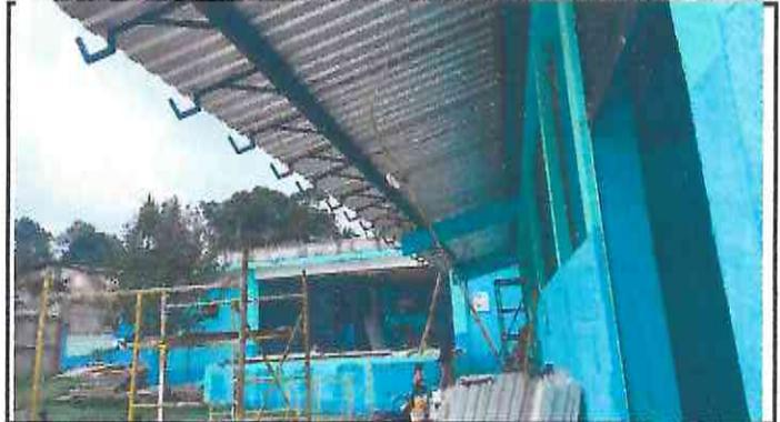
Foto 2: Colocacion de tubo para bajada de aguas pluviales
