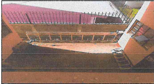
FOTO 1: SE NECESITA DOS PAREDES PARA LA COCINA
