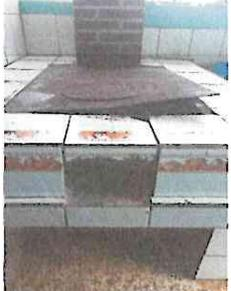
Foto 6: Plancha en mal estado
