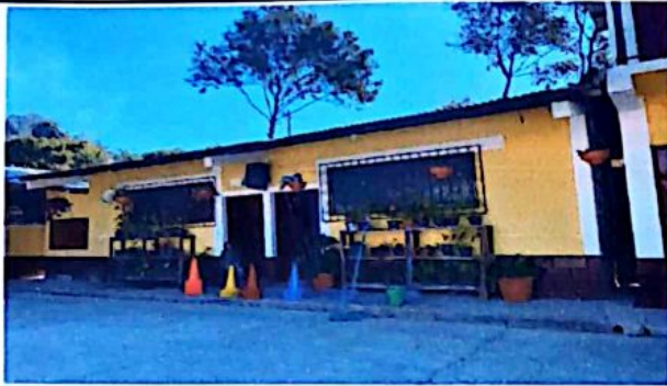
Foto 1: Techo del centro educativo en malas condiciones
