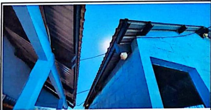
Foto 5: Falta capotera para bajadas de aguas de lluvias.
