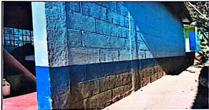
Foto 3: Pintura ya deteriorada.
