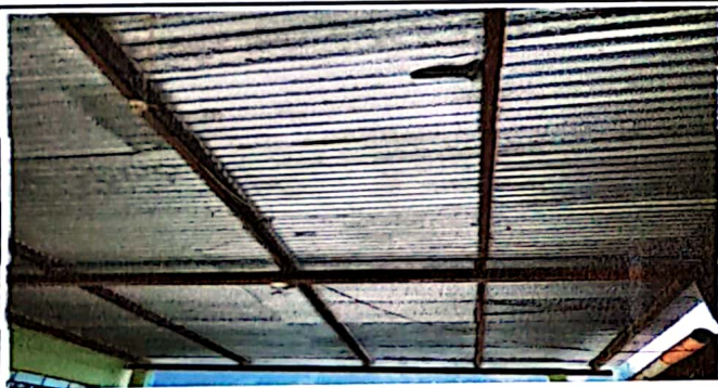
Foto No. 3: Cambio de lamina y pintura de costaneras.
