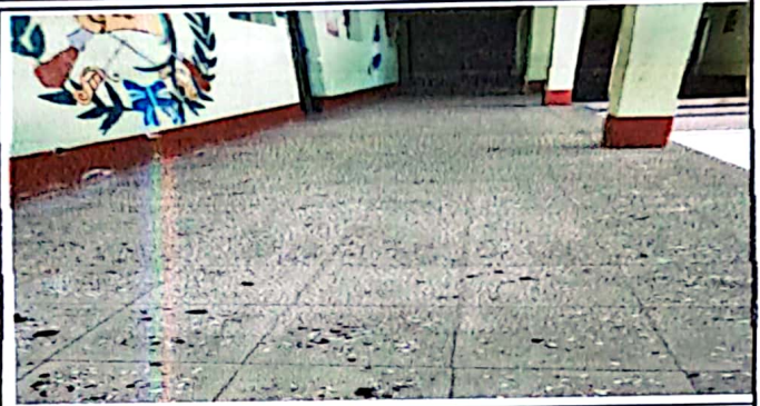
Foto No. 2: Cambio de piso de granito.
