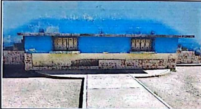
Foto 1: LAS VENTANAS Y LOS VALCONES ESTAN EN MAL ESTADO, LA MADERA DE LA VENTANA ESTA PICADA. ES NECESARIO CAMBIAR, LAS VENTANAS DE MADERA Y LOS VALCONES.
