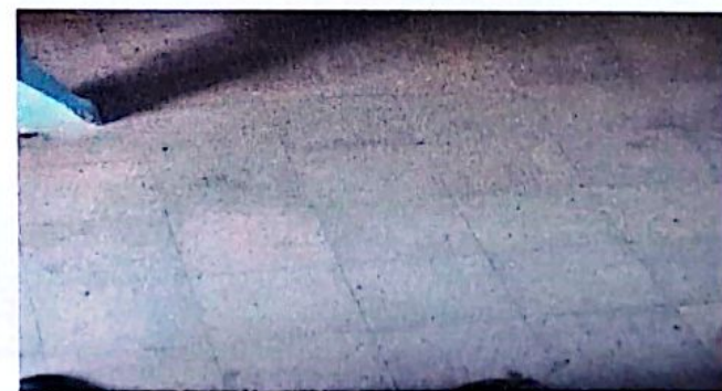
Foto 12: Piso del baño de mujeres que se va a remodelar
