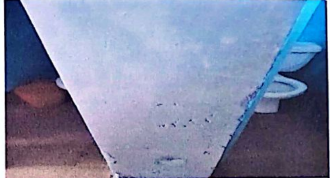
Foto 8: Servicio de Sanitarios de Señoritas
