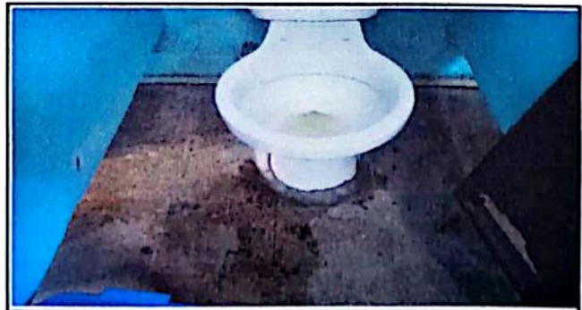
Foto 6: Servicios Sanitarios que se remodelara de los servicios de las señoritas
