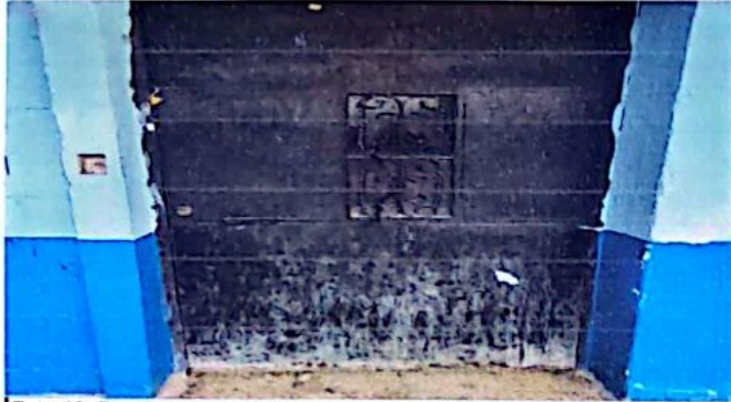
Foto 13: Puerta entreda de los servicios sanitarios
