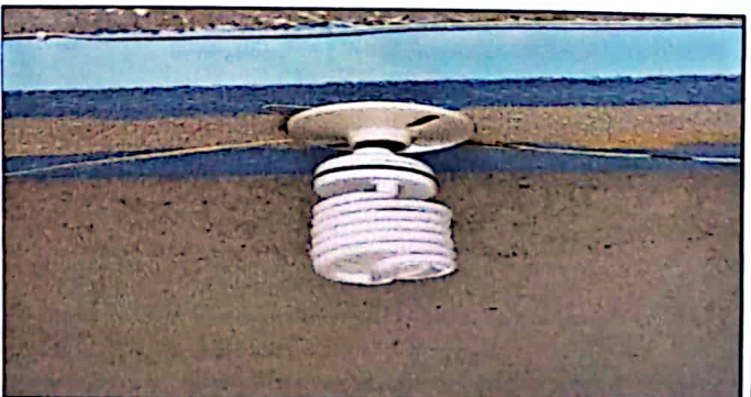
foto 6: sustitución de foco de iluminación de pasillo.
