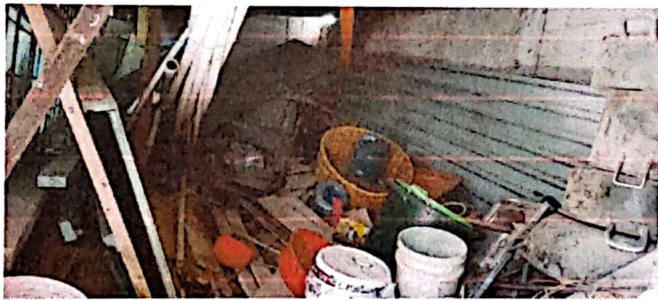
Foto 3: Construcción de bodega y ampliación de cocina
